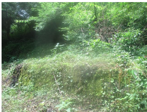
写真5 コンクリート基礎（墓地）
